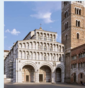
LUCCA DUOMO - consolidamento e protezione delle superfici in arenaria e marmo
