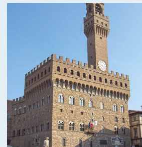
FIRENZE PALAZZO DELLA SIGNORIA - consolidamento e protezione delle superfici in arenaria
