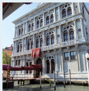
VENEZIA - casinò municipale di Venezia in Canal Grande - restauro della facciata
