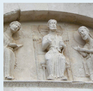
CHIETI PORTALE DELLA LUNA - pulitura, consolidamento e protezione degli elementi lapidei
