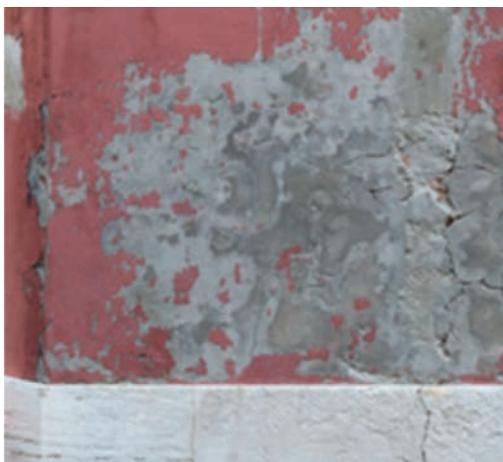
L'umidità ascendente o di risalita è la responsabile principale dei danni e del degrado di un edificio, soprattutto se antico o vecchio, e la si deve attribuire a due fattori principali come la presenza d'acqua nel sottosuolo e la porosità del materiale di costruzione.
