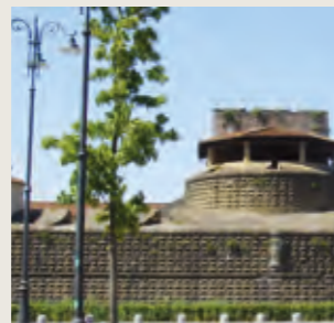
FIRENZE FORTEZZA DA BASSO - consolidation and protection of external walls
