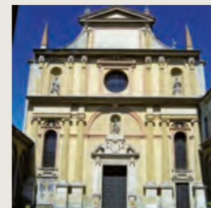
PIACENZA CHIESA DI SAN SAVINO - consolidation and conservative restoration
