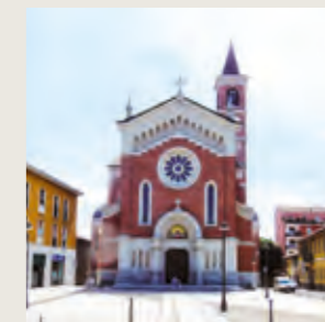
SAN VITTORE OLONA SS. MARTIRI VITTORE E SEBASTIANO - cleaning and protection of the facade
