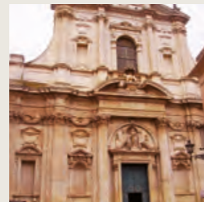
LECCE CHIESA DEI TEATINI - cleaning and protection of tuff materials
