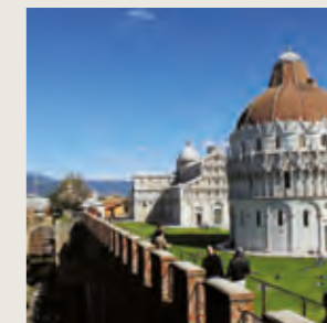
PISA PIAZZA DEI MIRACOLI - consolidation and protection of the walls
